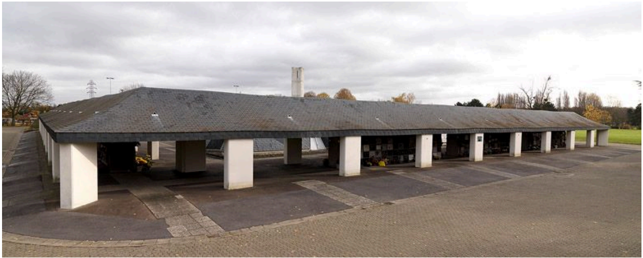
Vue extérieure d'un portique de l'ossuaire individuel, devenu colombarium.
