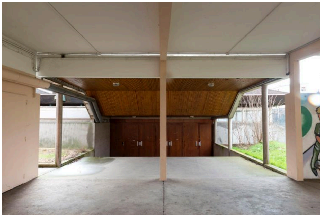
Lycée Saint-Exupéry : entrée de la salle polyvalente ajoutée dans les années 70.
