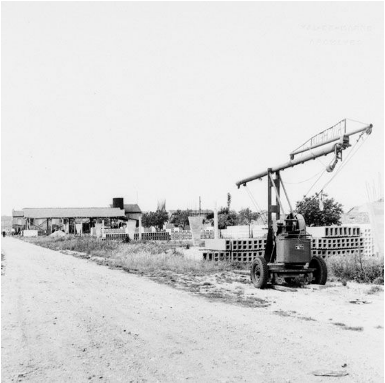
Chantier d'une opération de castors non identifiée. Photographie, 1955. (AD Val-de-Marne. 2Fi Champigny 252)
