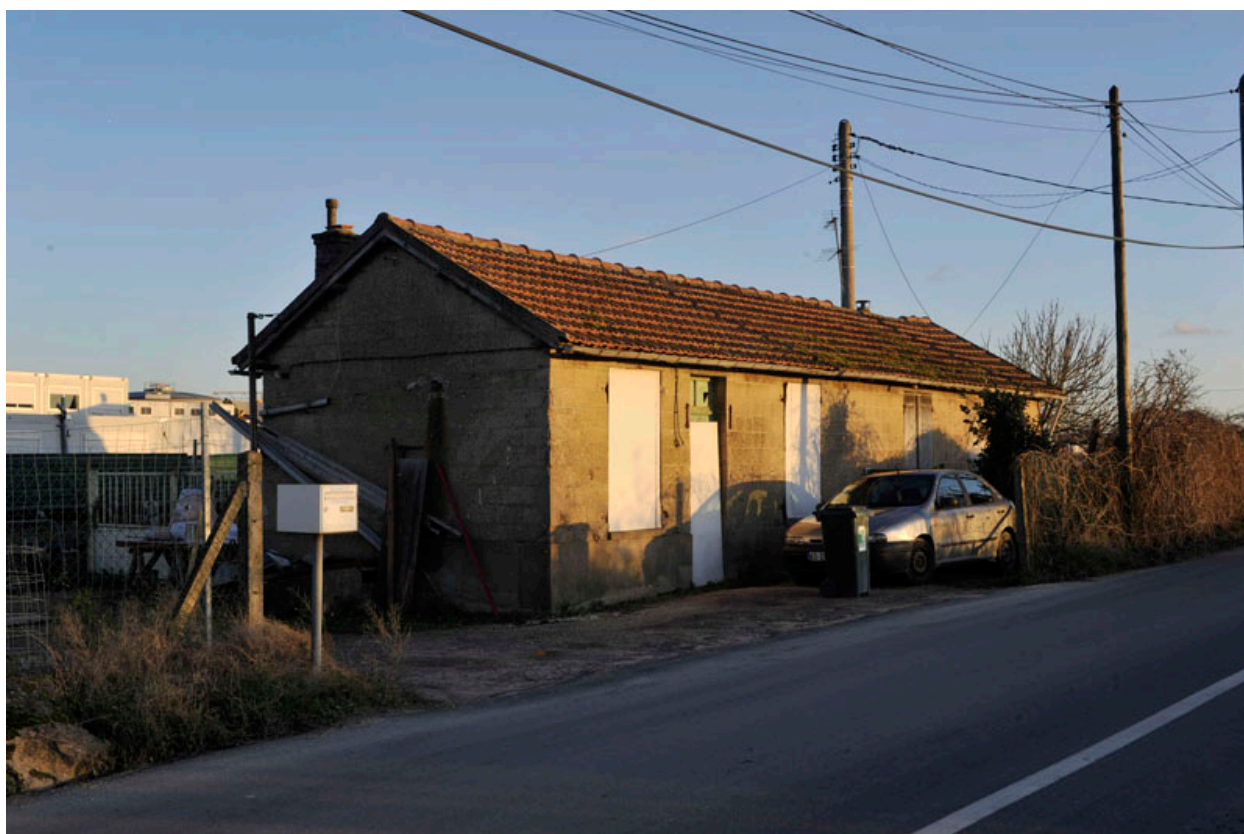
Triel-sur-Seine, carrière (sablère et gravière) Lafarge Granulats, 2 chemin des Graviers. Ancien bâtiment d'exploitation.
