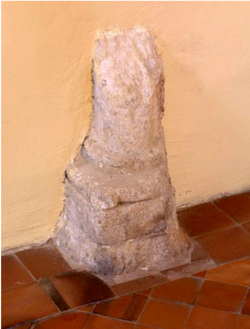
La salle basse orientale : vestige d'une base de colonnette, engagée dans le mur sud.
