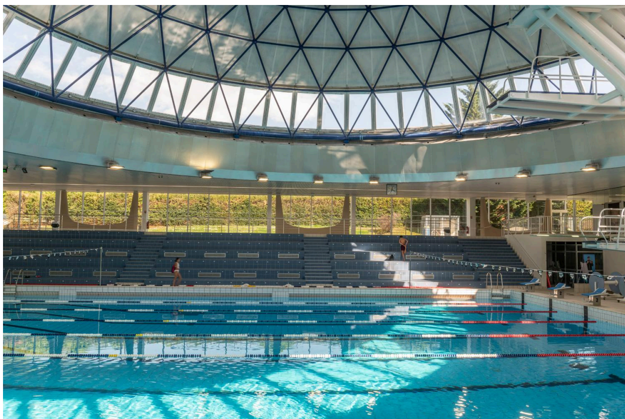
Bassin olympique, gradins et mur-rideau, vue intérieure depuis l'ouest
