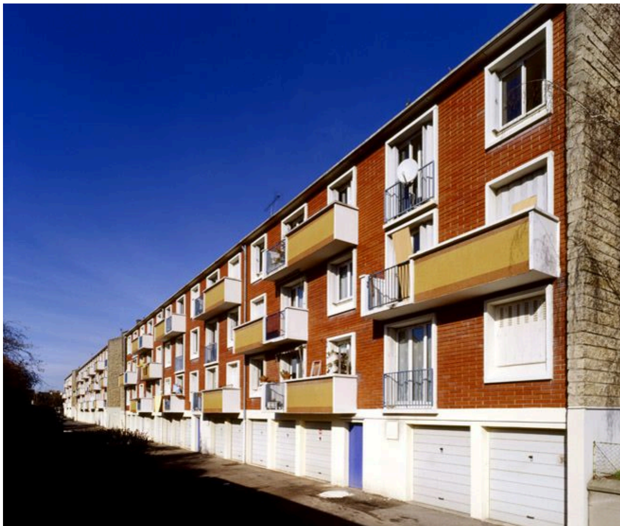
Cité, rue André Chenier. Détail de la mise en oeuvre des balcons d'un des immeubles.
