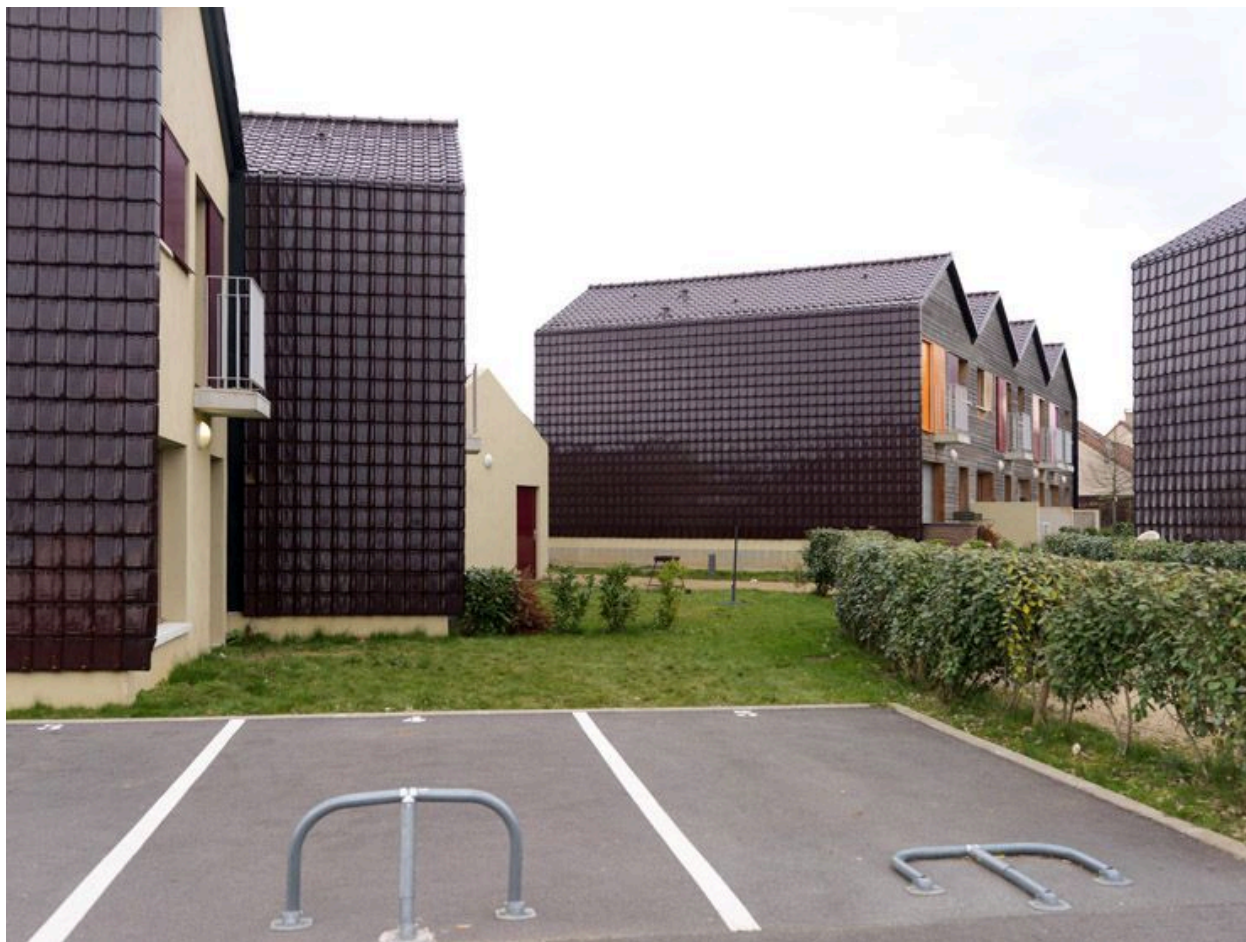
Villiers-le-Bâcle, rue de Bartillat. Quartier résidentiel.
