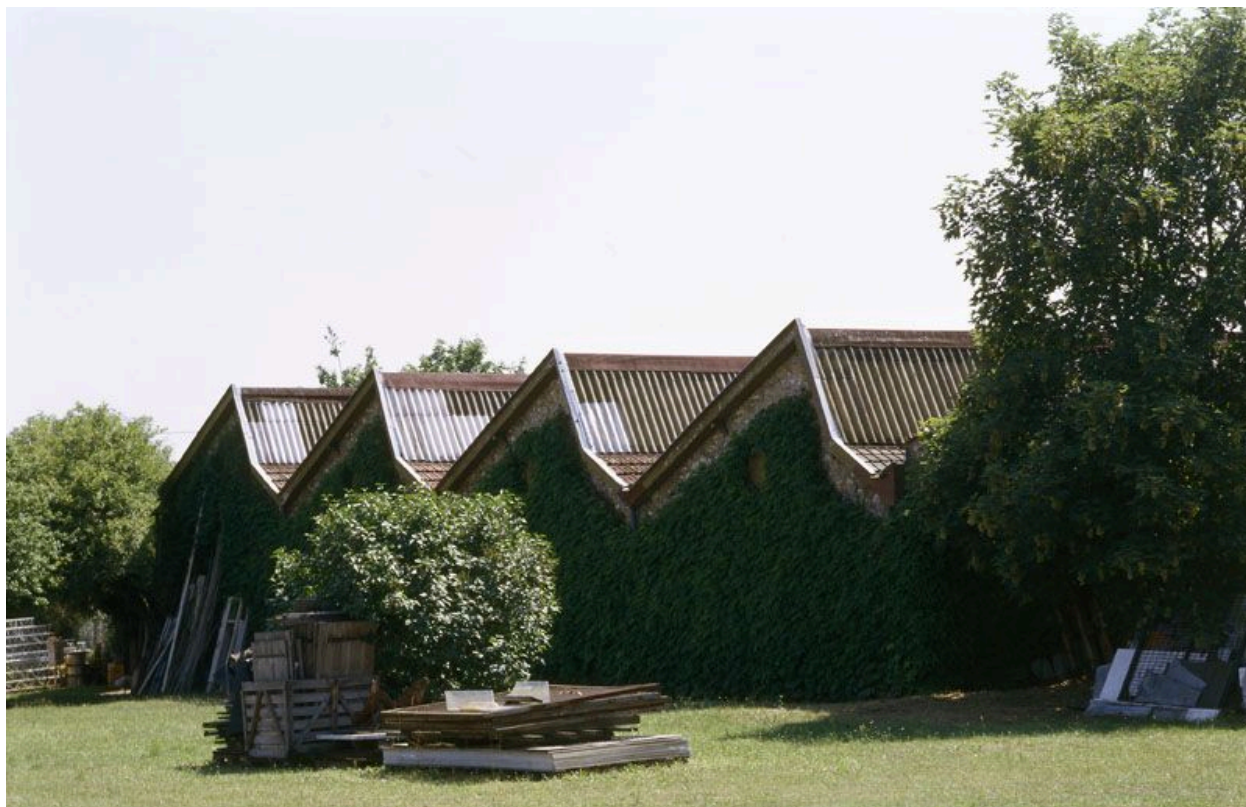
Vue d'ensemble des ateliers.
