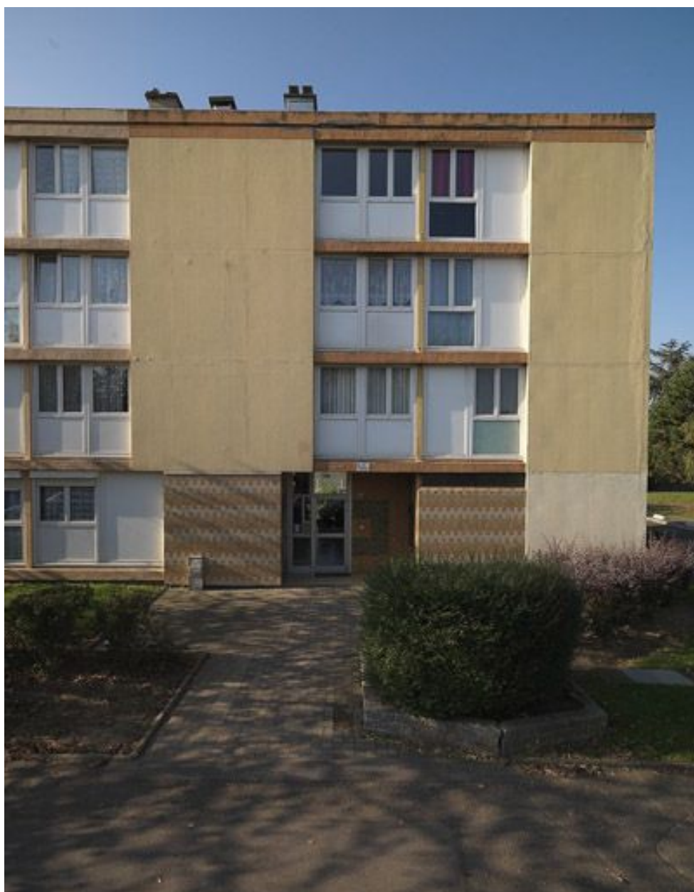
Détail d'une travée d'un immeuble R+3, 14 avenue de la Concorde.
