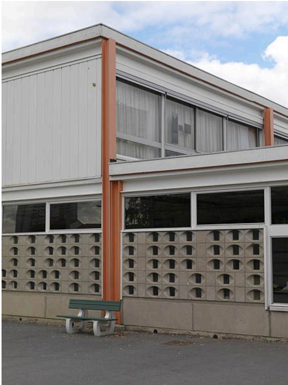
L'école primaire du groupe scolaire Alain : autre vue du décor de claustra en béton.
