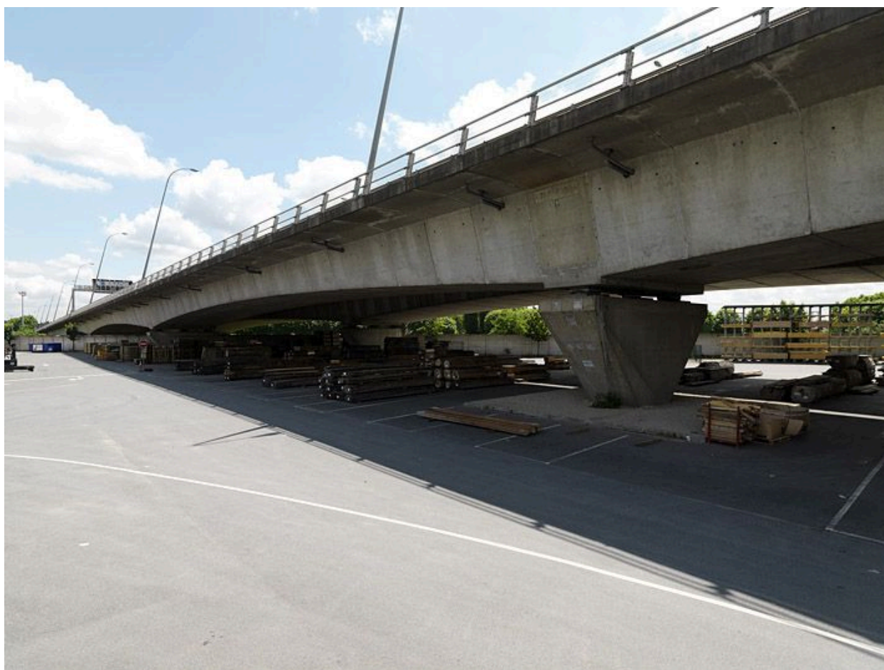
Choisy-le-Roi, Alfortville, Vitry-sur-Seine. Pont de Choisy de l'A86. Vue du départ du viaduc de la darse d'Alfortville.
