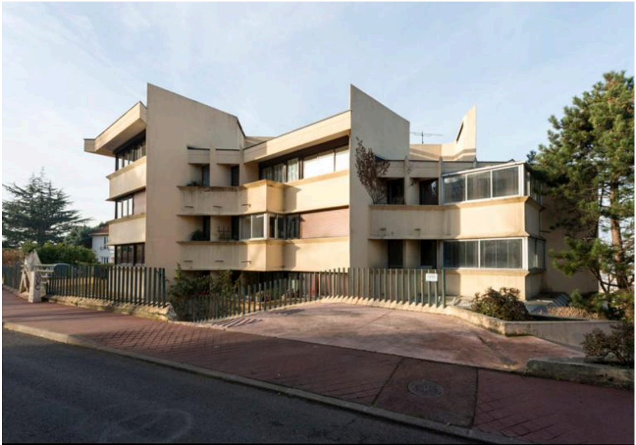
Vue latérale de la façade.
