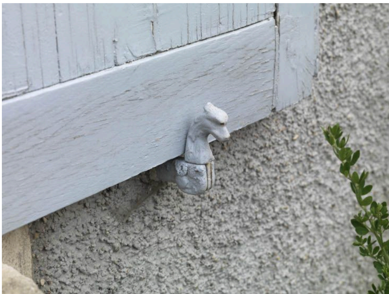
Maison d'habitation, arrêt de volet.
