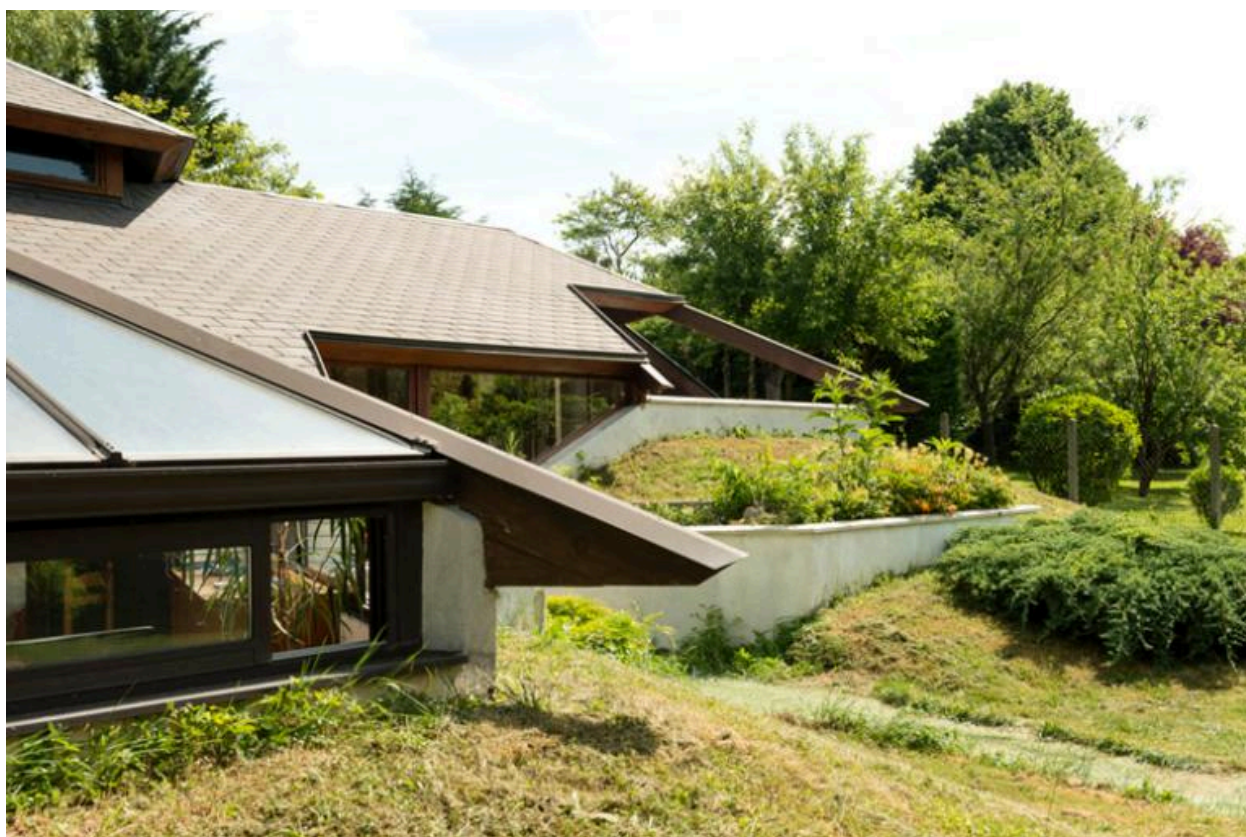
Détail des toits de la façade principale
