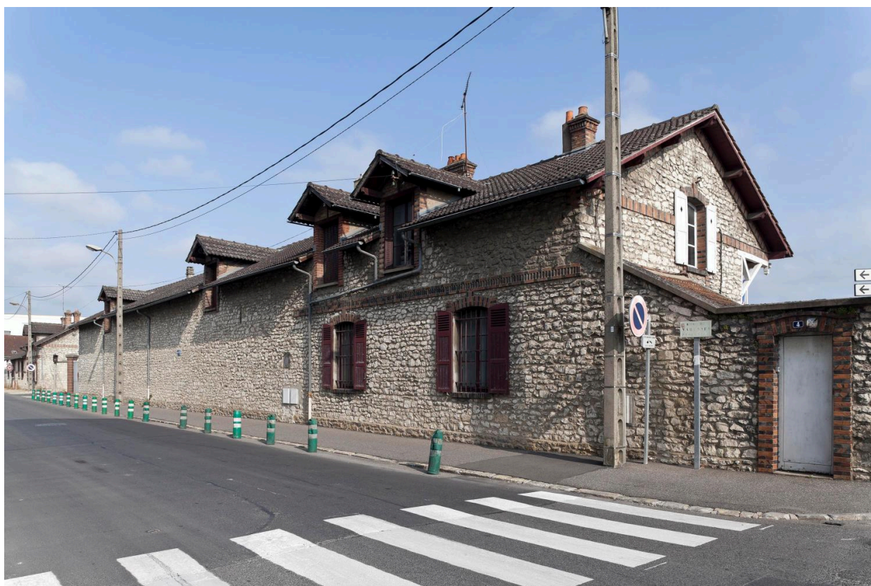
Bâtiments administratifs, ancienne scierie Jodot, avant 1934. (réf. Département de Seine-et-Marne : IVD77_2013_77_00297_NUCA)
