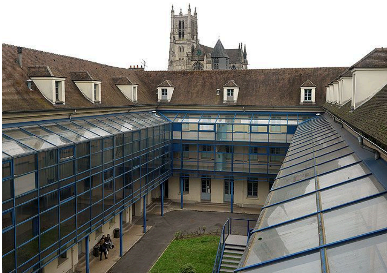
La cour intérieure, vue depuis les combles (vue rapprochée).
