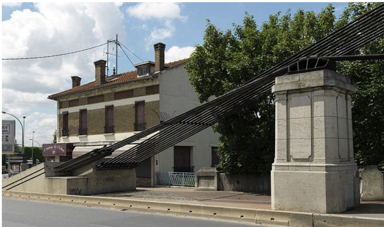
Vitry-sur-Seine, Alfortville. Pont de Port-à-l'Anglais. Détail des tirants fixant les câbles, côté Vitry.
