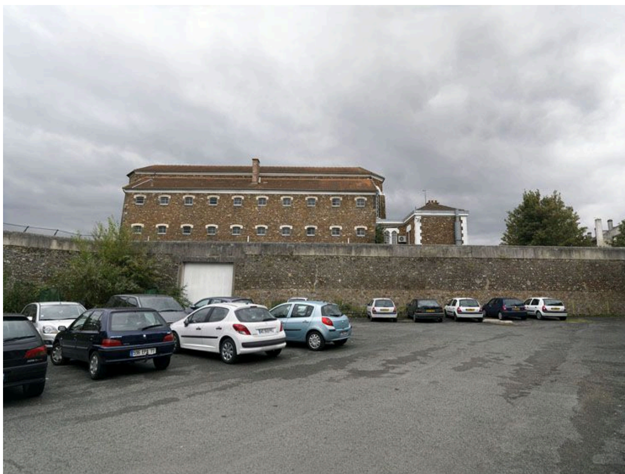
Vue d'ensemble, depuis la cour de la gendarmerie (au nord).
