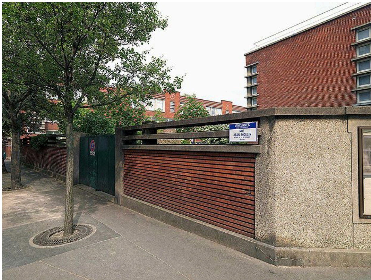
94, Vincennes, groupe scolaire dit groupe scolaire du Sud, 8 rue Lebel . Mur de clôture de brique sur la rue Jean-Moulin.
