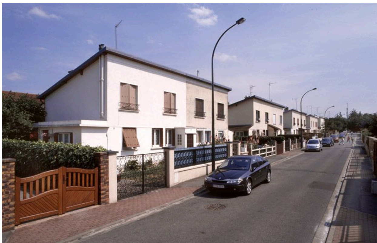
Lotissement concerté dit Castors du bâtiment, rue de la Pipée. Vue générale de maisons jumelles. Dastugue, M. et Bivort, Ch. (architectes)
