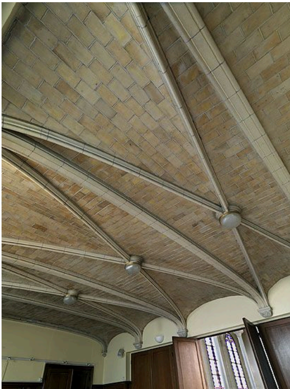
92, Neuilly-surSeine, église paroissiale Saint-Jean-Baptiste, 69 rue de l'Eglise. Vue intérieure des voûtes de brique de la salle introduisant à la chapelle de l'Annonciation.
