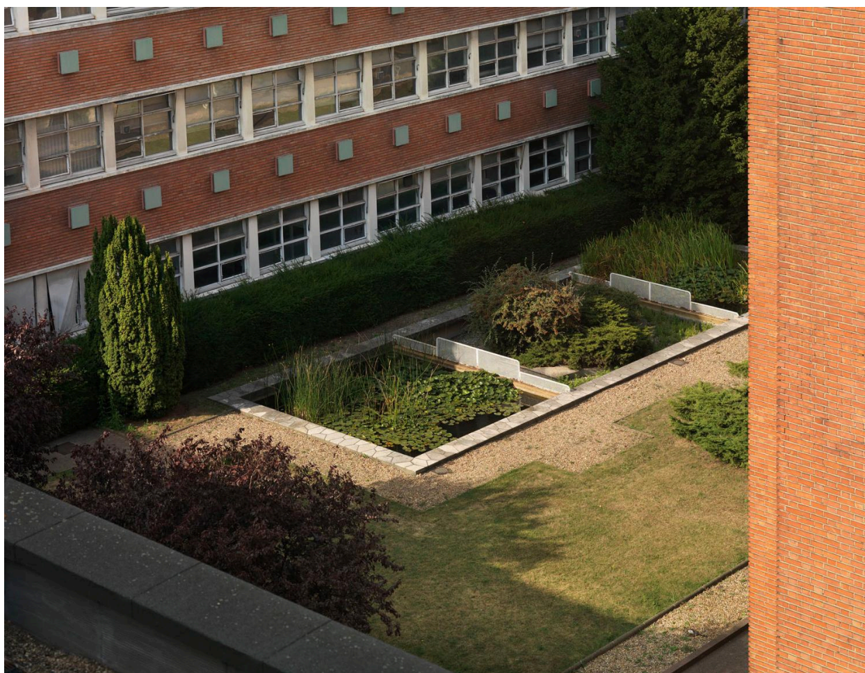
Site Sanofi, vue du bâtiment de recherches.
