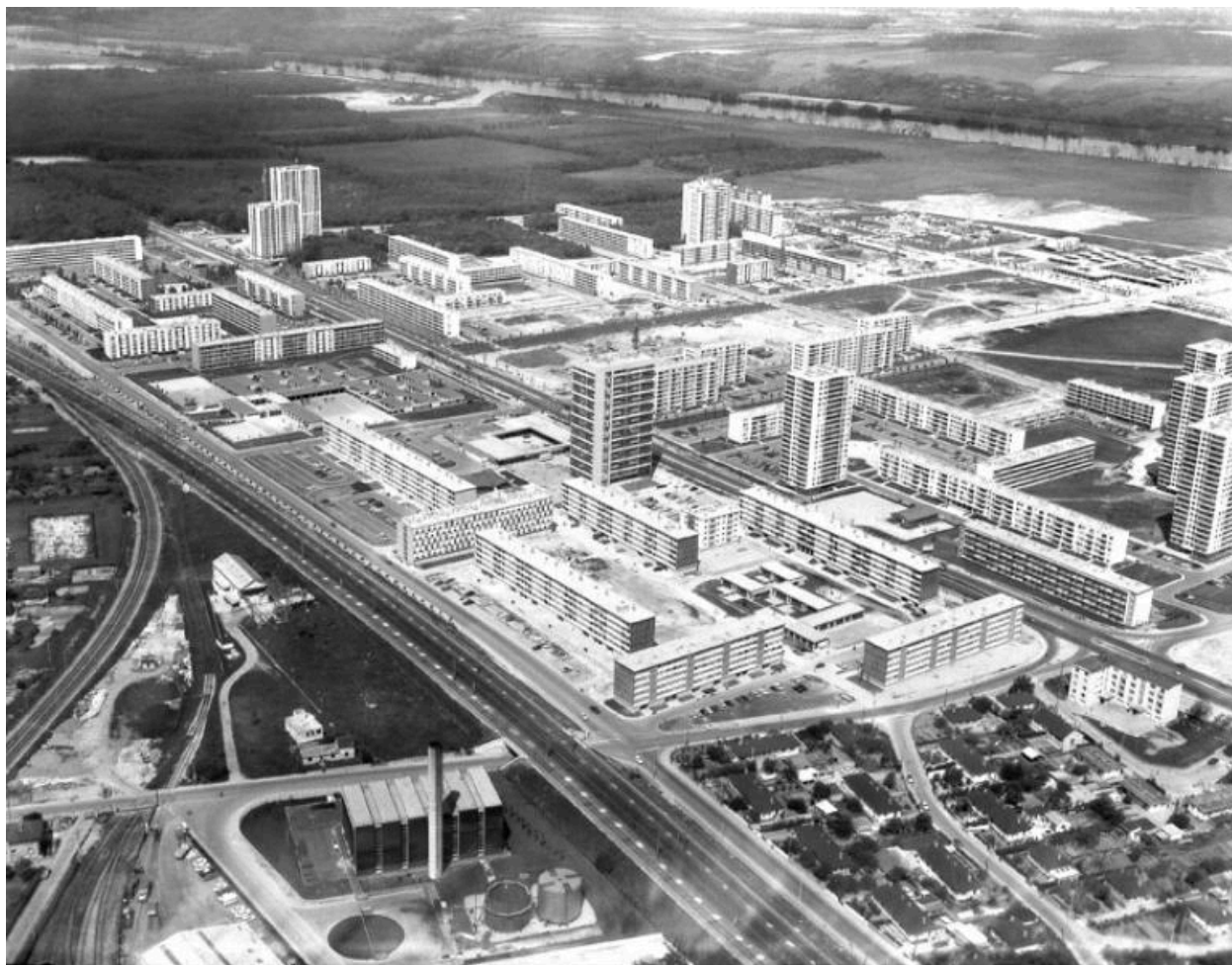
Vue aérienne vers l'ouest des quartiers construits vers 1970. Quartiers 2, 1 3 et 4. (Fonds Bertin).
