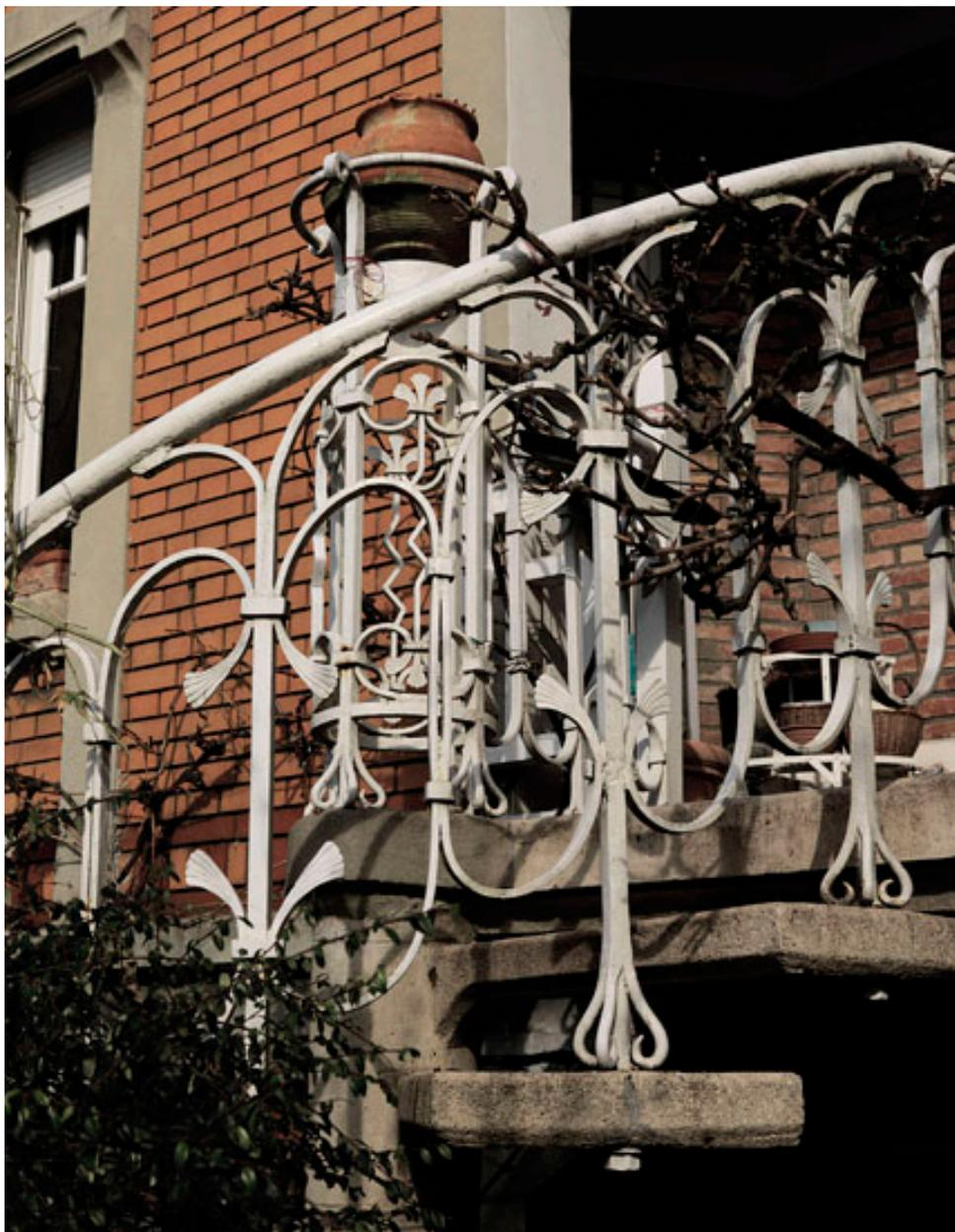
Détail de l'escalier, balustrade en ferronnerie, probablement dessinée par Emile Robert, ferronnier d'art. La balustrade est fixée par des rivets dans les marches en béton.
