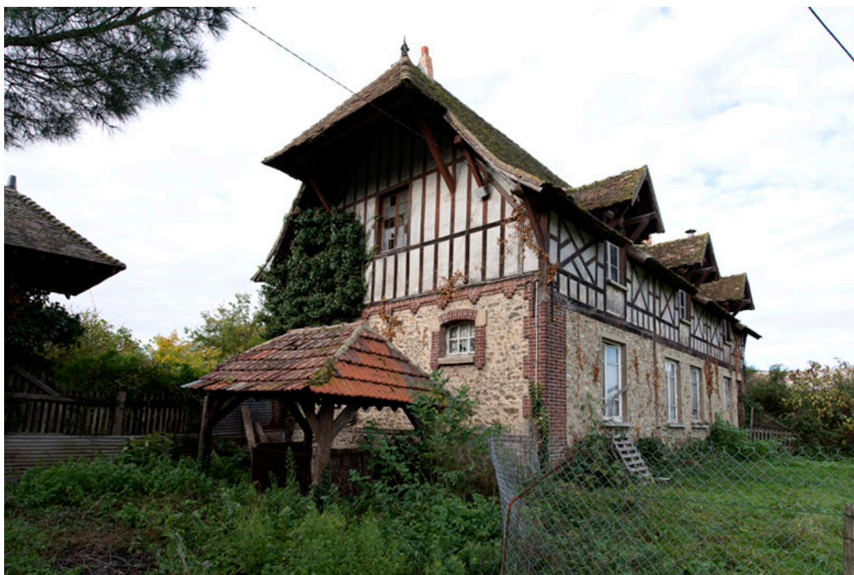
Le pignon de la grange et son élégante demi-croupe surmontée d'un épi de faîtage.
