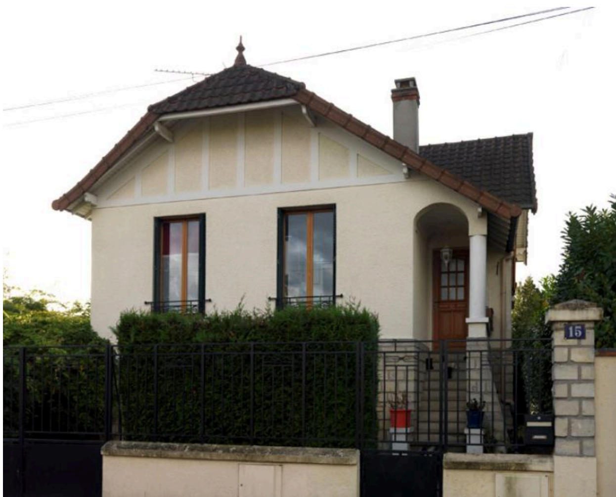
Vue de la maison située au n°15 rue Saint-Fiacre.
