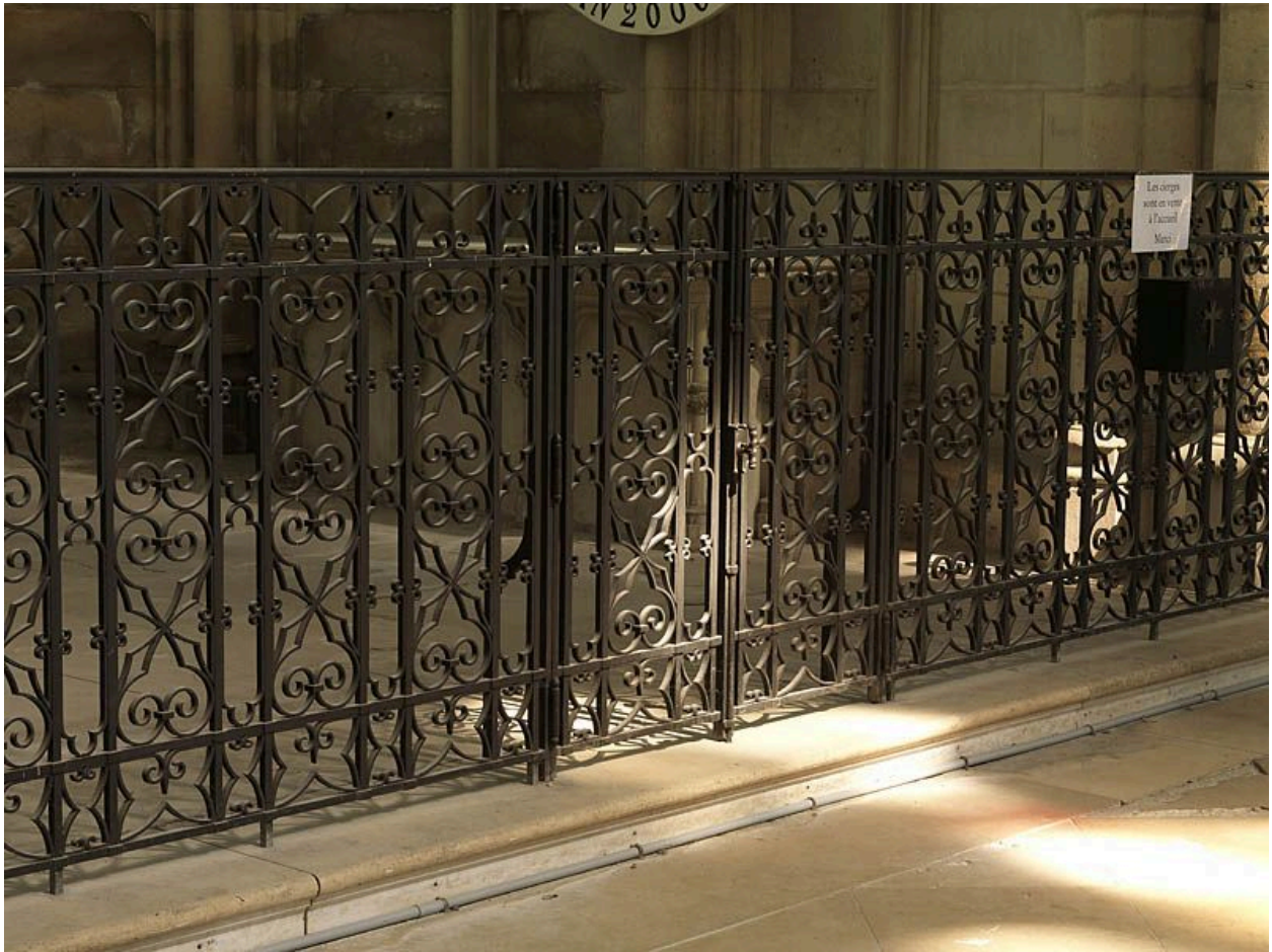
La grille de la 2e chapelle rayonnante nord (chapelle Saint-Jean l'Evangeliste), formant paire avec celle de la chapelle voisine (chapelle Saint-Jacques).
