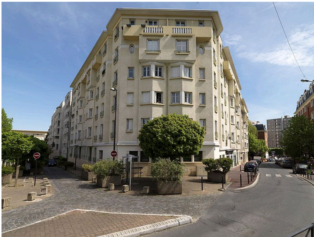
Vitry-sur-Seine, immeuble, 2 bis avenue Ambroise Croizat. Vue de l'angle du bâtiment construit par Paul Pelletier et Arthur Tesseire.
