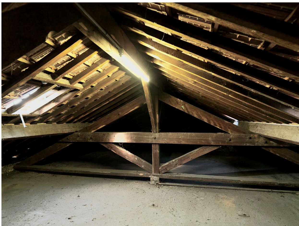
Vue de la charpenste des pavillons d'angle
