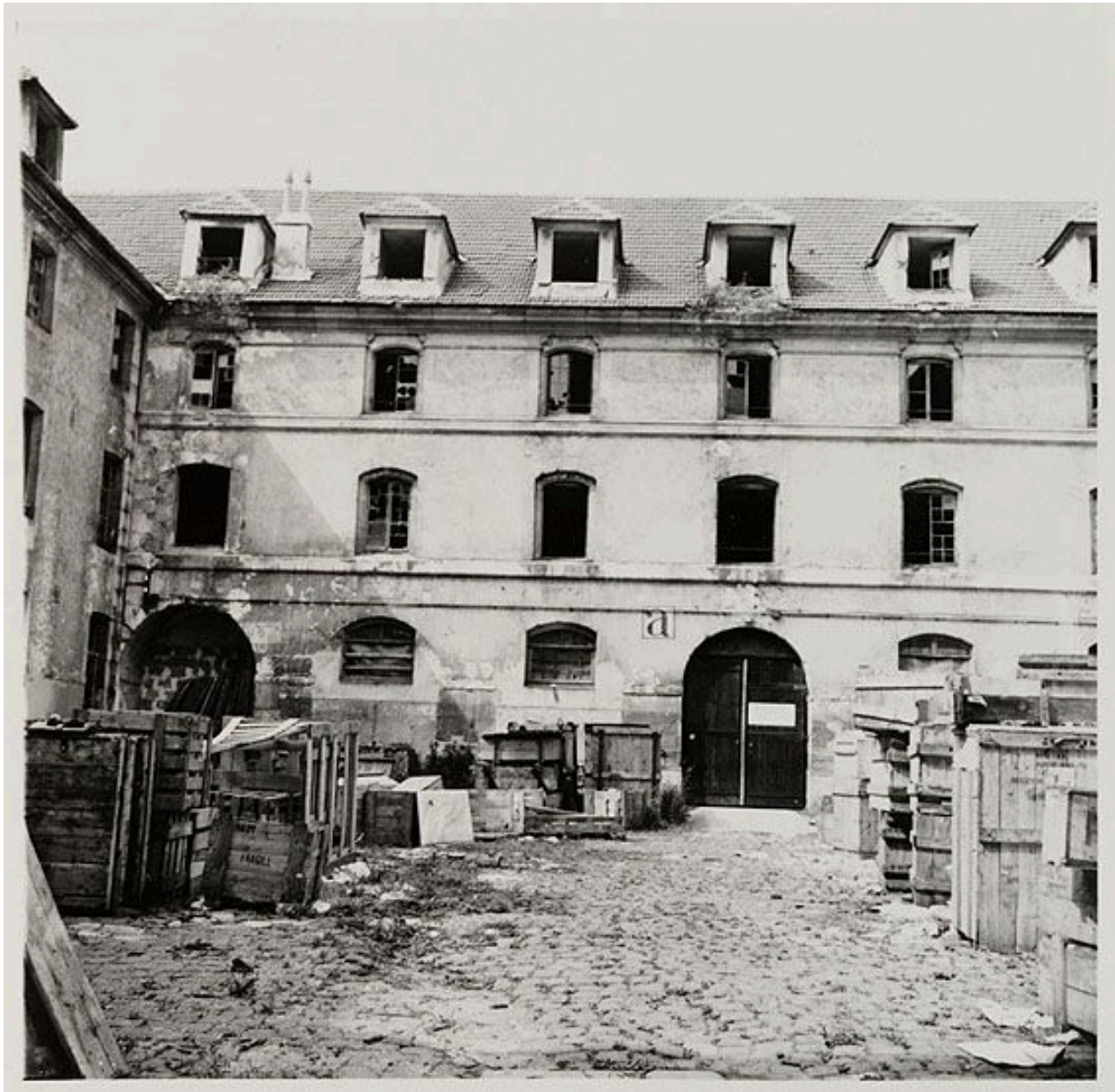
Photographie des anciens bâtiments de l'abbaye Notre-Dame du Marché, reconvertie en quartier de cavalerie, avant démolition : vue extérieure. Photographie, vers 1965. (Médiathèque Luxembourg, Meaux. Fonds Endrès )
