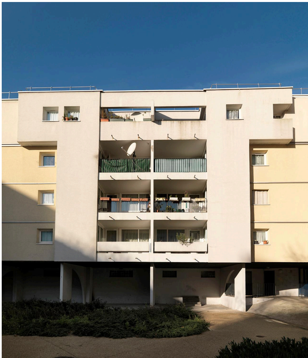
Cité Jacques Duclos. Détail d'un bâtiment.
