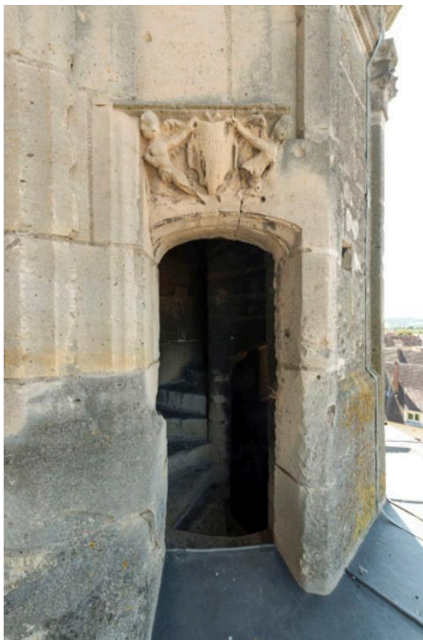
Escalier en vis à marches formant noyau desservant la tour.
