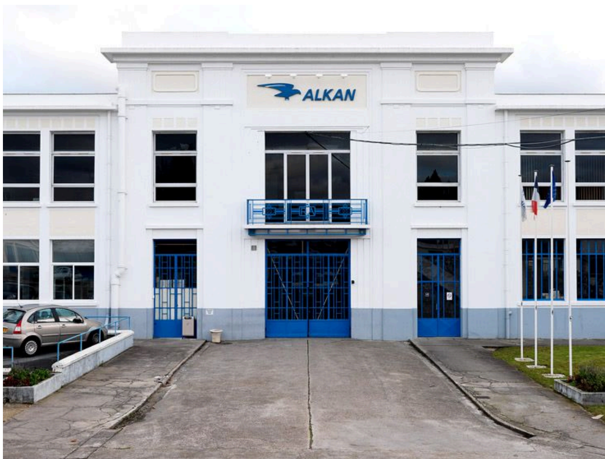
Valenton, usine Alkan, rue du 8 Mai 1945. Détail du pavillon d'axe du bâtiment des bureaux.
