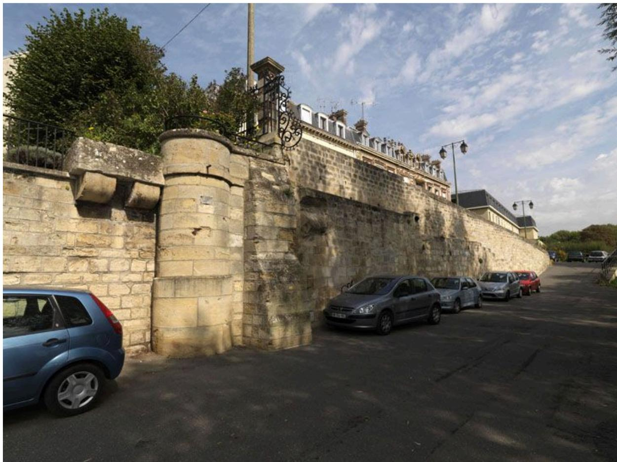
Vestiges de la naissance du pont. On aperçoit le début d'une arche et deux encorbellements identiques à ceux du Petit Pont.
