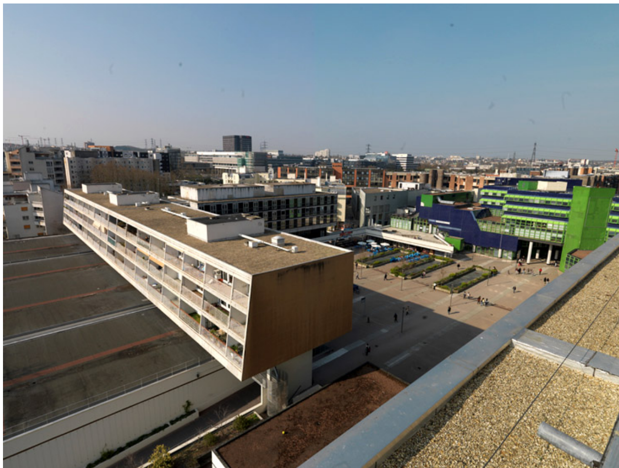
Le centre culturel et administratif André Malraux vu depuis le toit de la préfecture.
