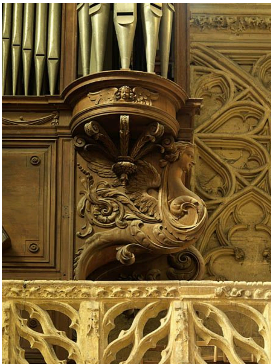
Partie basse de la tourelle nord et balustrade de la tribune.
