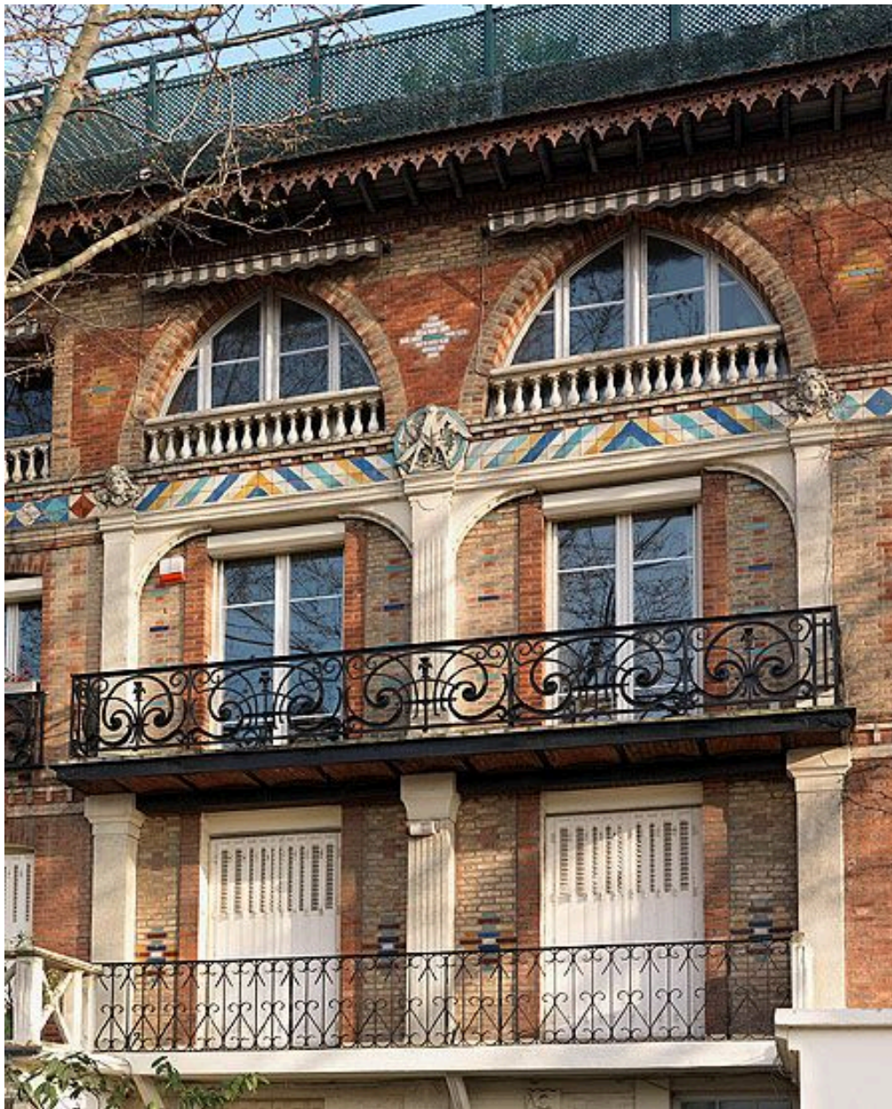
92, Neuilly-sur-Seine, maison, 70 boulevard Bourdon. Détail de l'élévation de la maison de brique à structure métallique.
