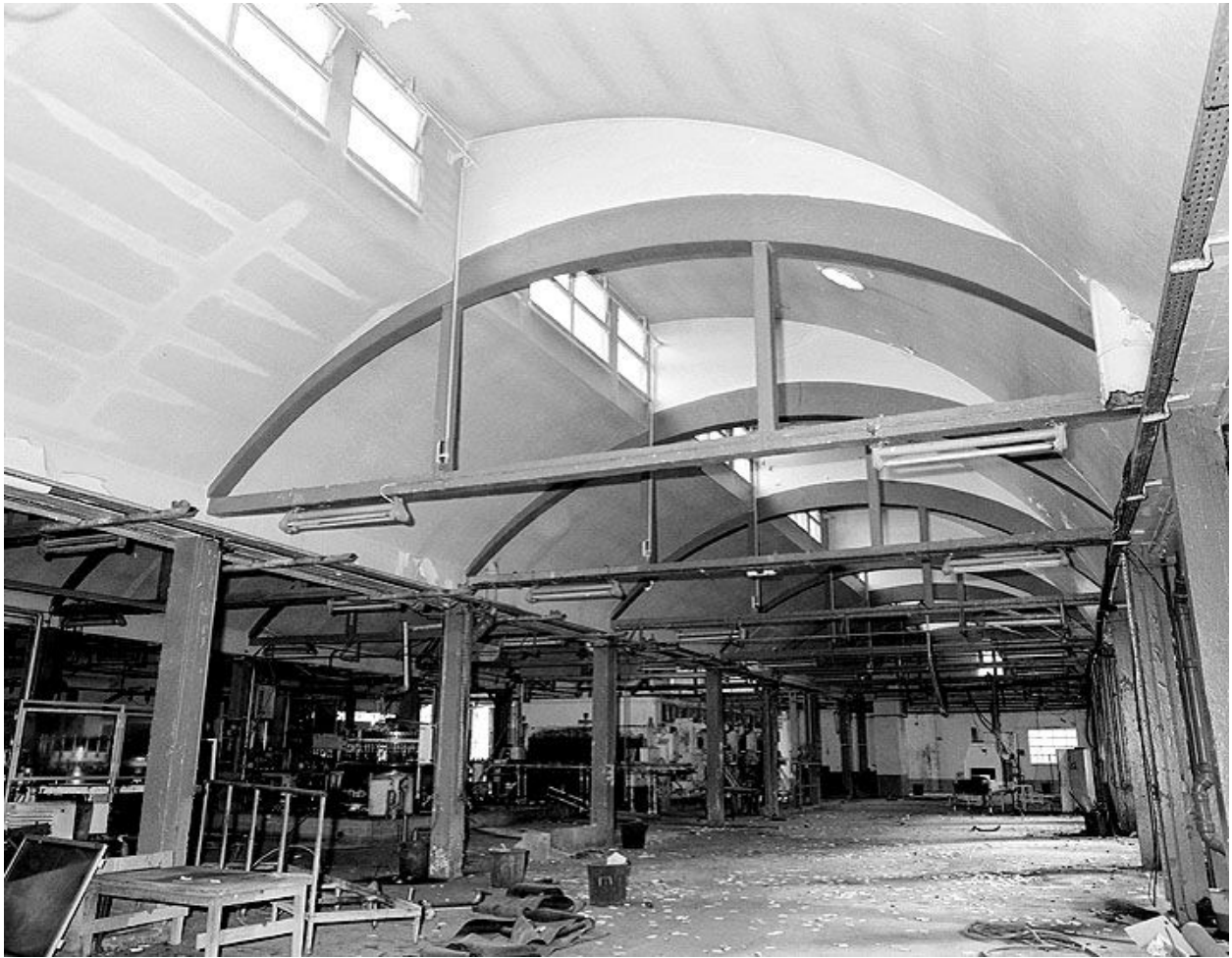
Le hall d'embouteillage : vue intérieure. Photographie avant destruction, 1989. (Ministère de la culture, Inventaire général. 89SG707X)
