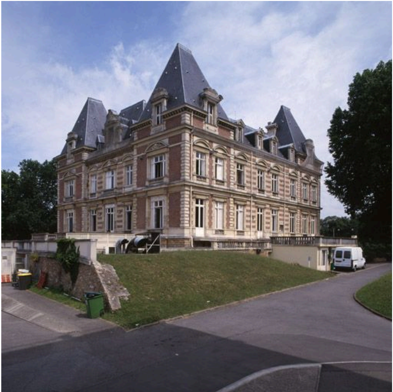
Façades postérieure et latérale ouest.
