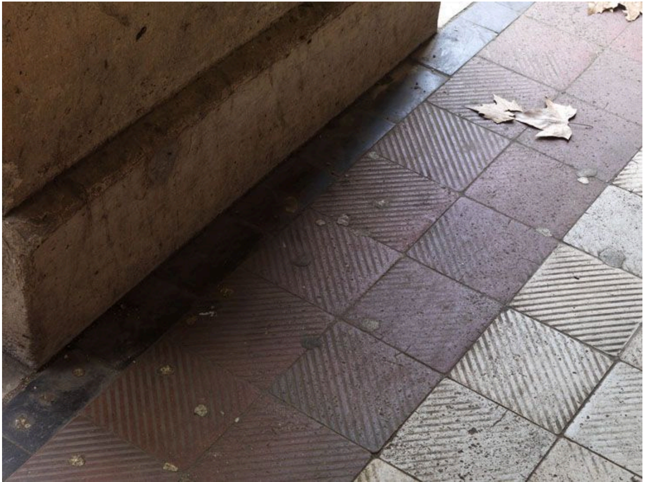
92, Sceaux, lycée Lakanal, 3-7 avenue du Président-Franklin-Roosevelt. Grande galerie nord-sud : carrelages anti-dérapants.
