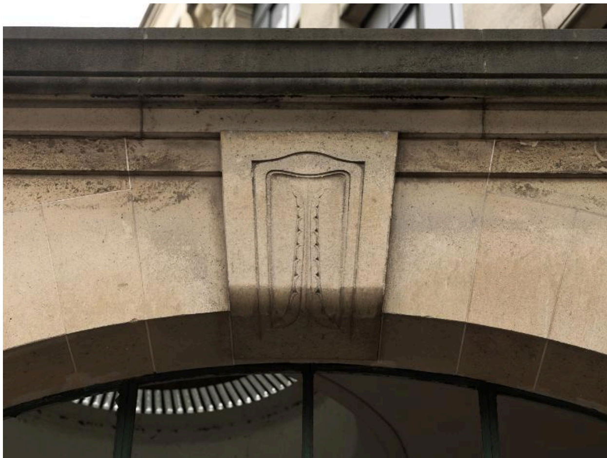
Détail de la clef de voûte de l'entrée de service sud-ouest.
