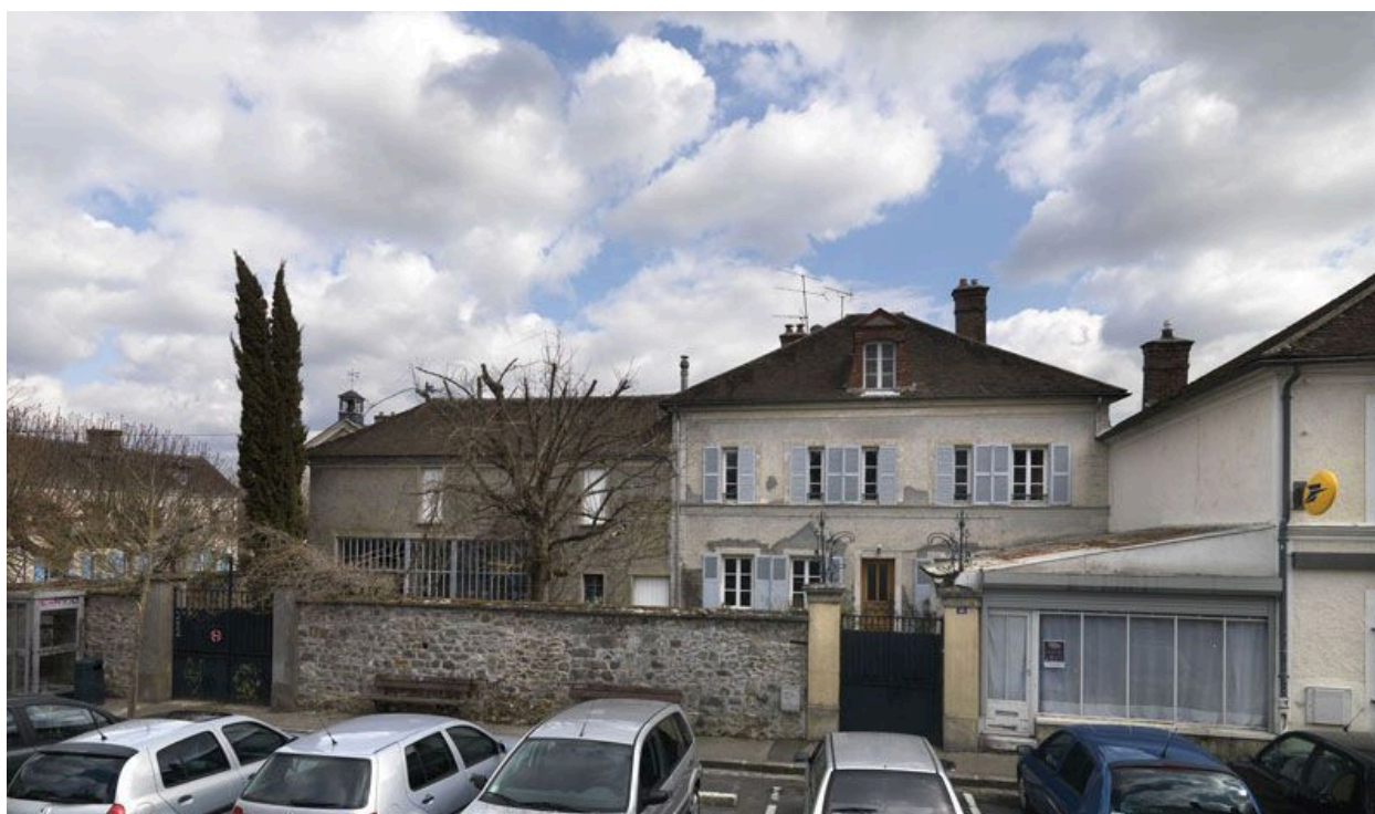
Vue générale de l'ancienne usine de serrurerie.
