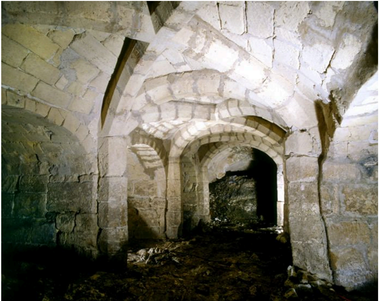
Vue de la cave de l'hôtel-restaurant Aux caveaux du vieux monastère, 75 rue Louis Talamoni. Vue actuelle du premier niveau de cave.
