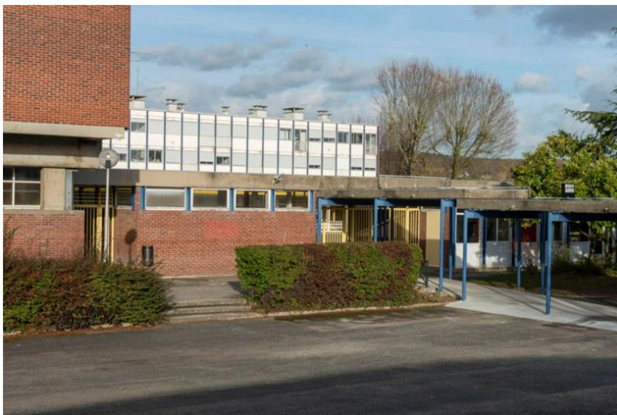
Lycée Rostand : galerie reliant le patio aux réfectoires.
