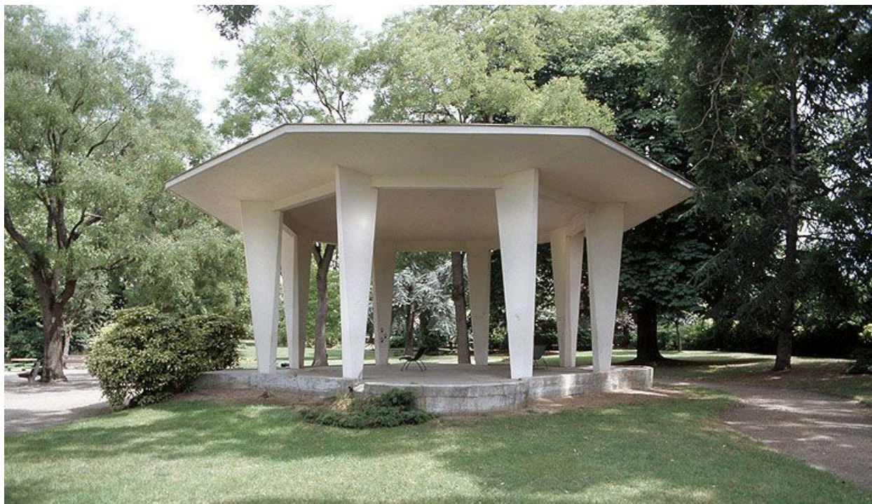
Vue du kiosque dans le parc du Saut du Loup, 4 rue d'Estienne d'Orves.
