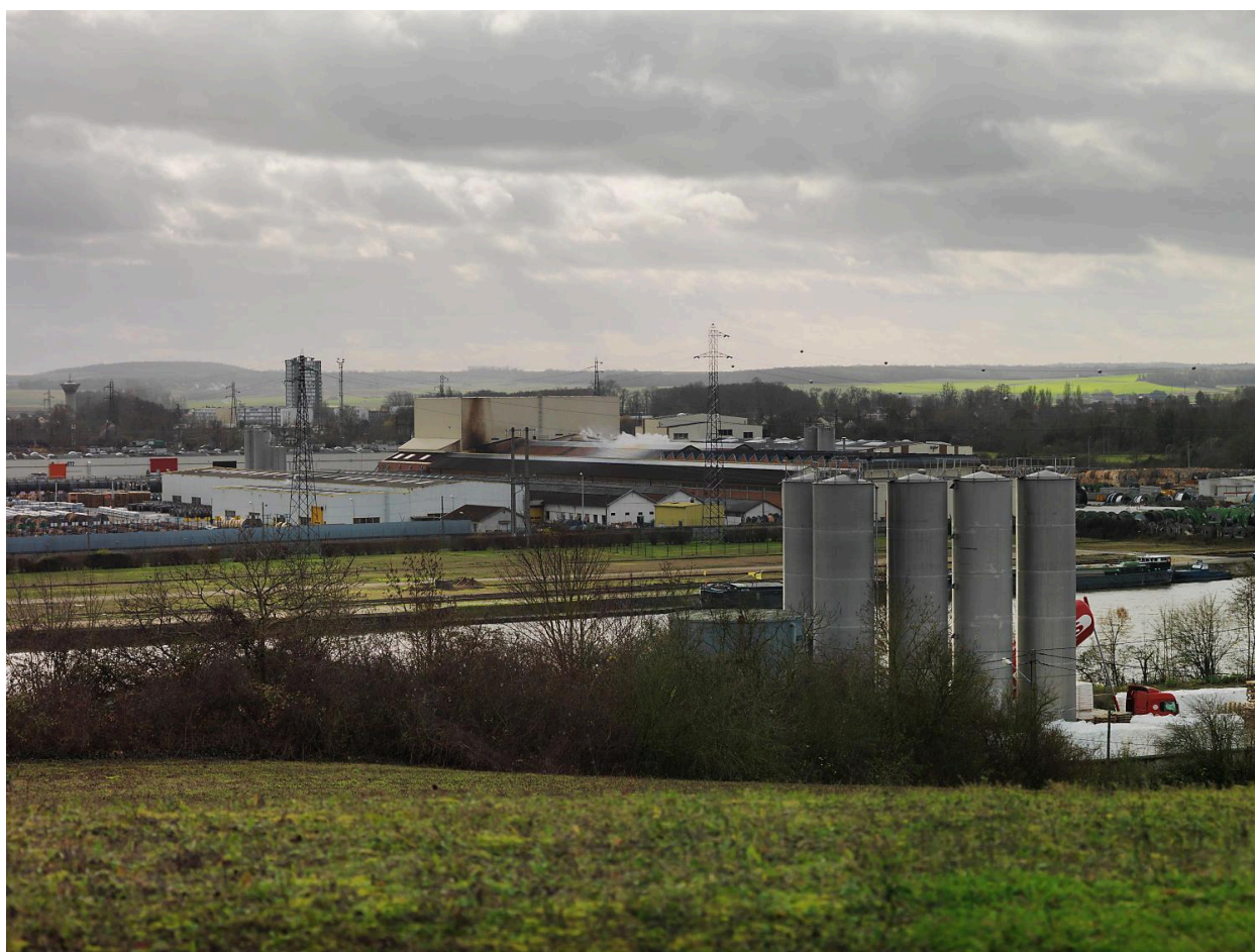
La SILEC dans le paysage, vue sur les anciens établissements Besson partiellement couverts de sheds (actuellement ateliers CC2 SILEC).
