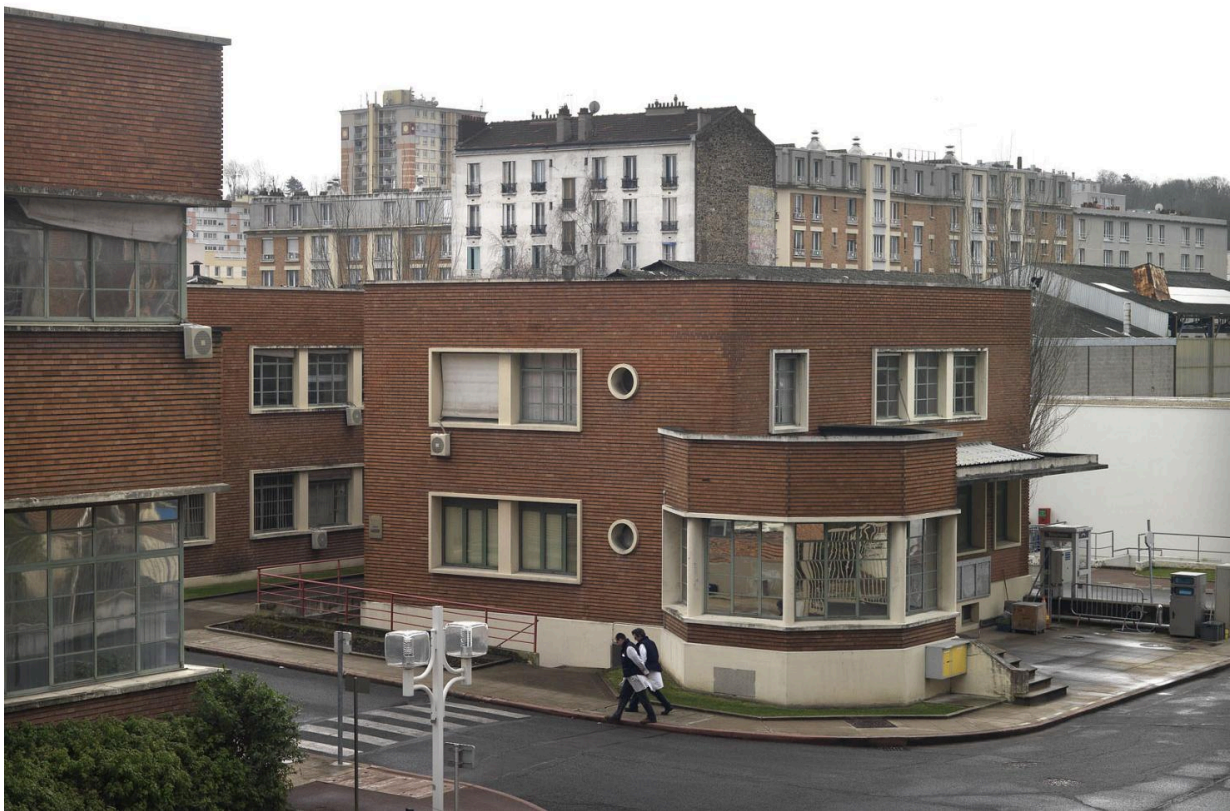
Site Sanofi. Vue extérieure du bâtiment d'accueil.
