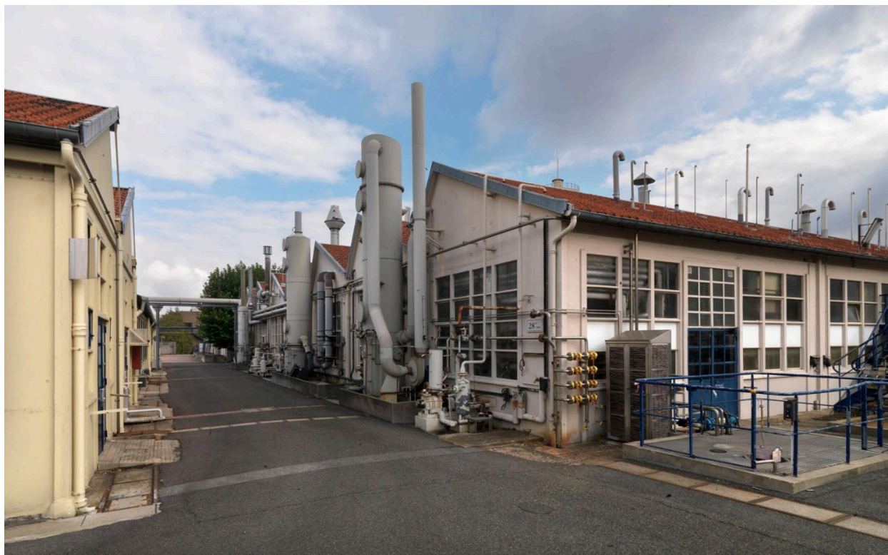
Site Biocitech, vue des rues intérieures.
