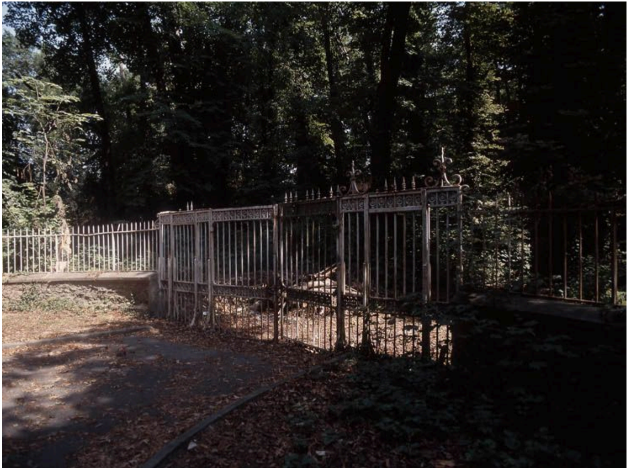
Vue de la grille située au bas de la propriété, sur le chemin du Bas de Champrosay.
